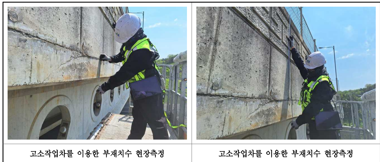
【사진 2.2.2】 부재 현장측정 전경
