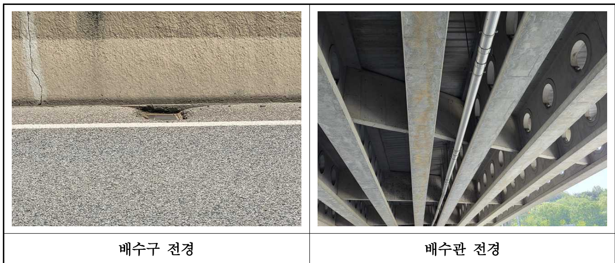
【사진 2.3.21】 배수시설 전경
