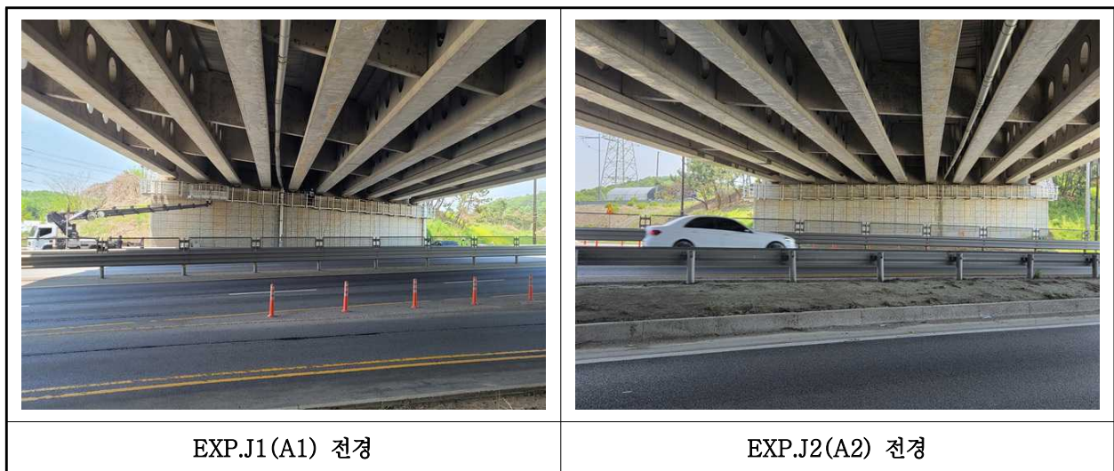
【사진 2.3.16】 신축이음장치 전경
