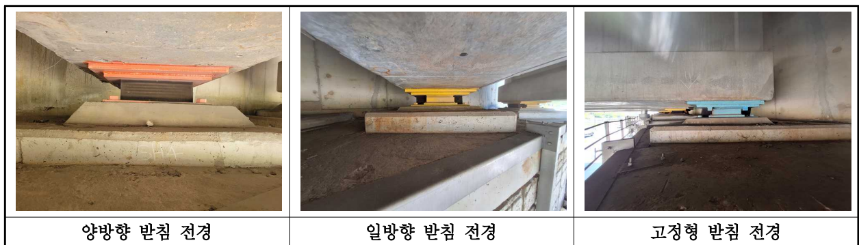
【사진 2.3.12】 교량받침 전경
