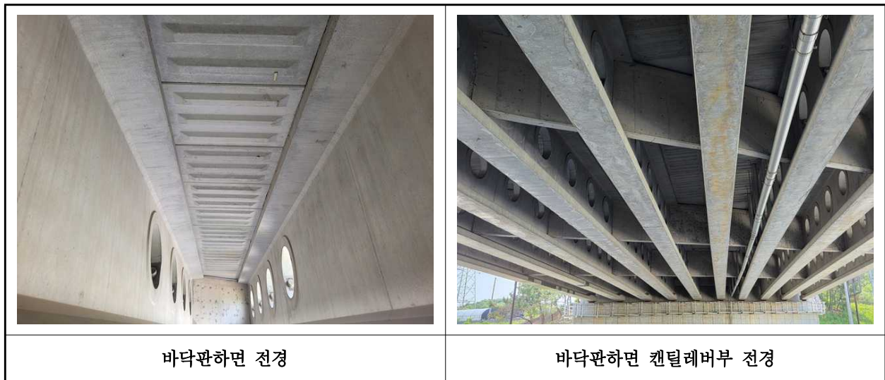
【사진 2.3.2】 바닥판하면 전경
