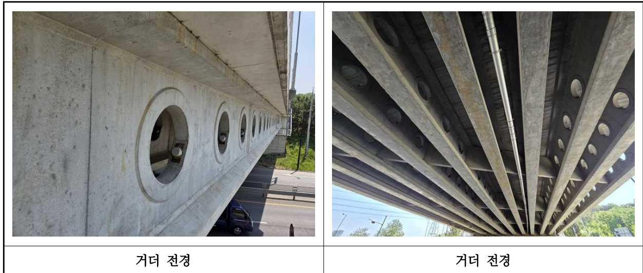
【사진 2.3.4】 거더 전경
