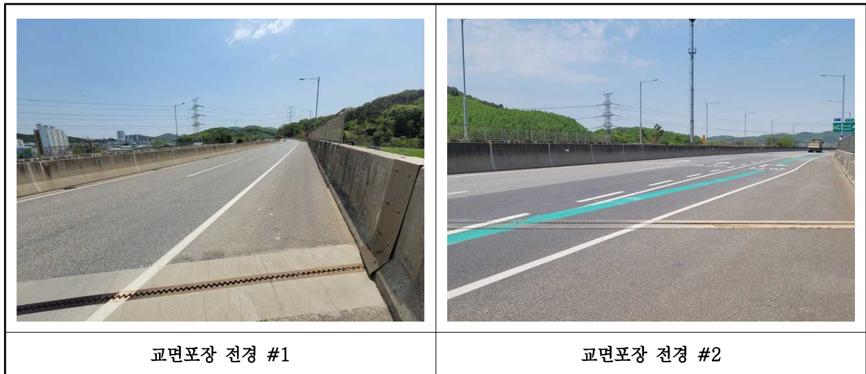
【사진 2.3.19】 교면포장 전경
