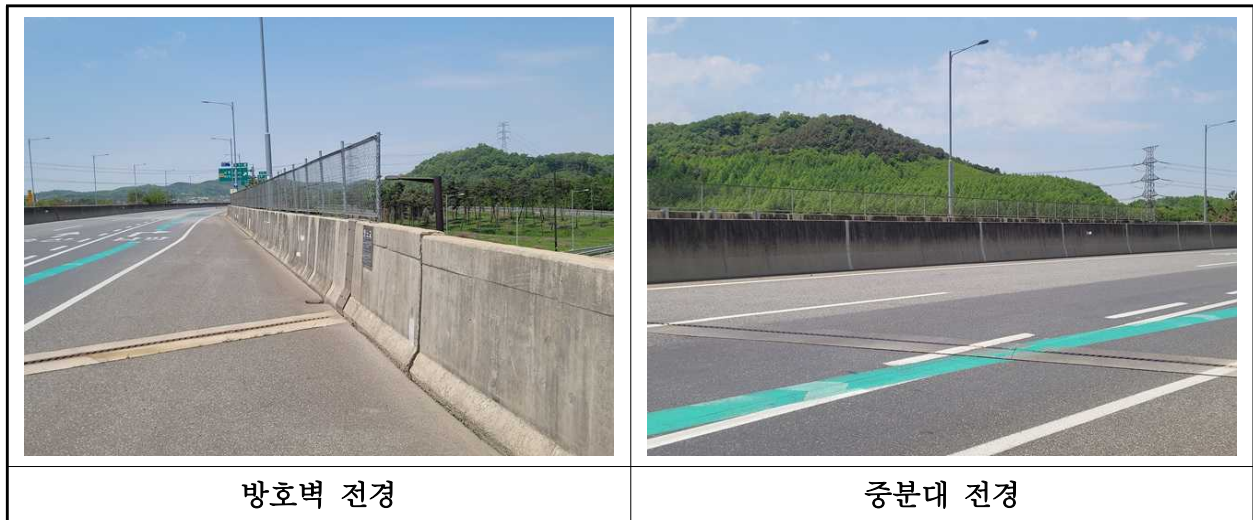
【사진 2.3.23】 방호벽 및 중분대 전경
