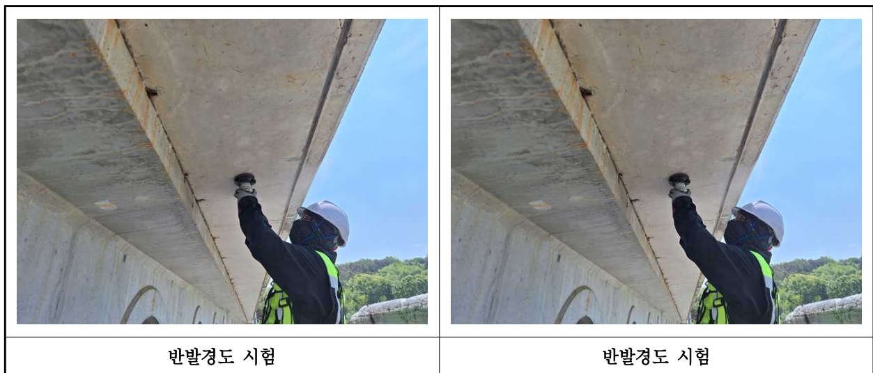
【사진 2.4.2】 반발경도시험 현장사진
