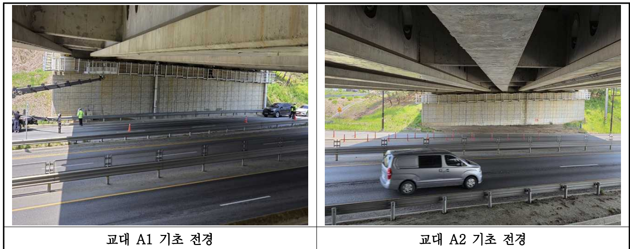
【사진 2.3.11】 기초 전경
