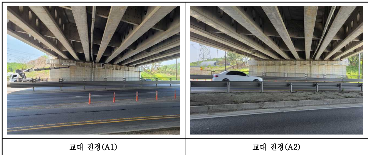
【사진 2.3.8】 교대 전경
