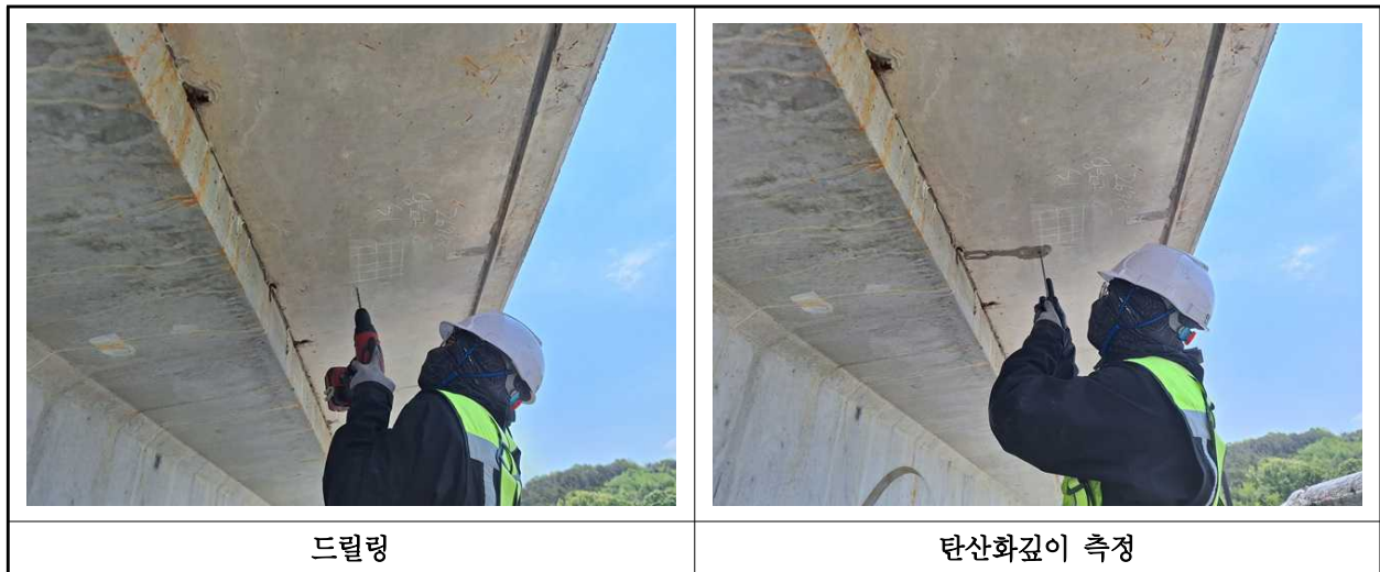
【사진 2.4.3】 탄산화 깊이 측정 현장사진
