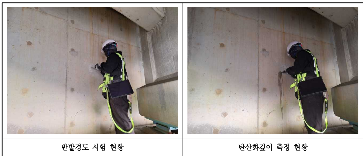
【사진 2.4.1】 콘크리트 내구성조사 현황
