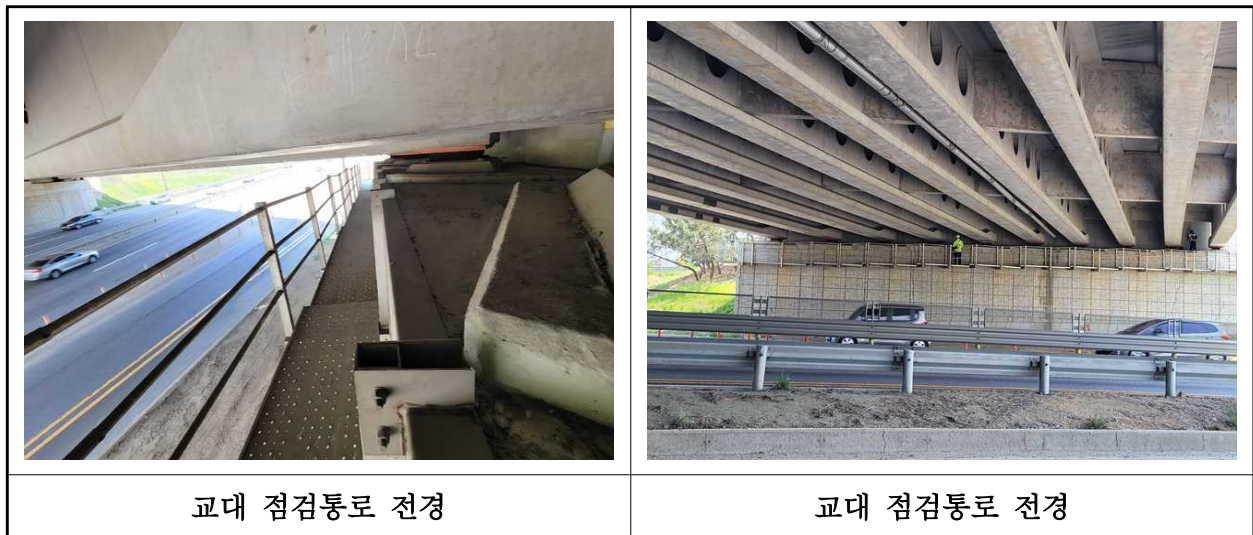
【사진 2.3.25】 교량 점검시설 전경
